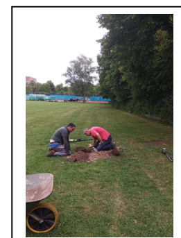
Bild 3: Vorbereitungen zur Munitions- ortung
