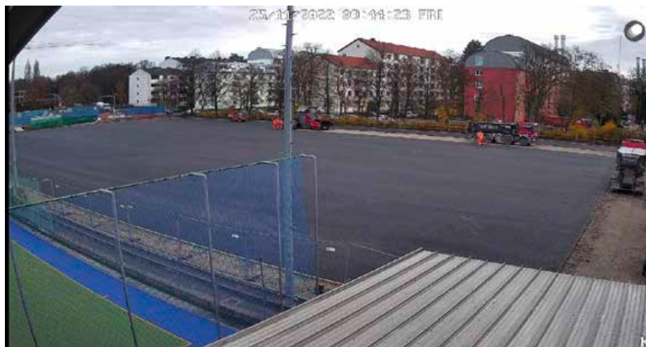
AUGUST 22 Beginn der Bauarbeiten
